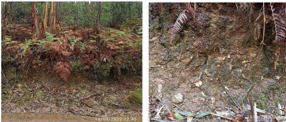
Figura 12 – Aspeto geral do local de acesso a criar para o apoio 47 (acima) e aspeto em detalhe do talude (abaixo)
