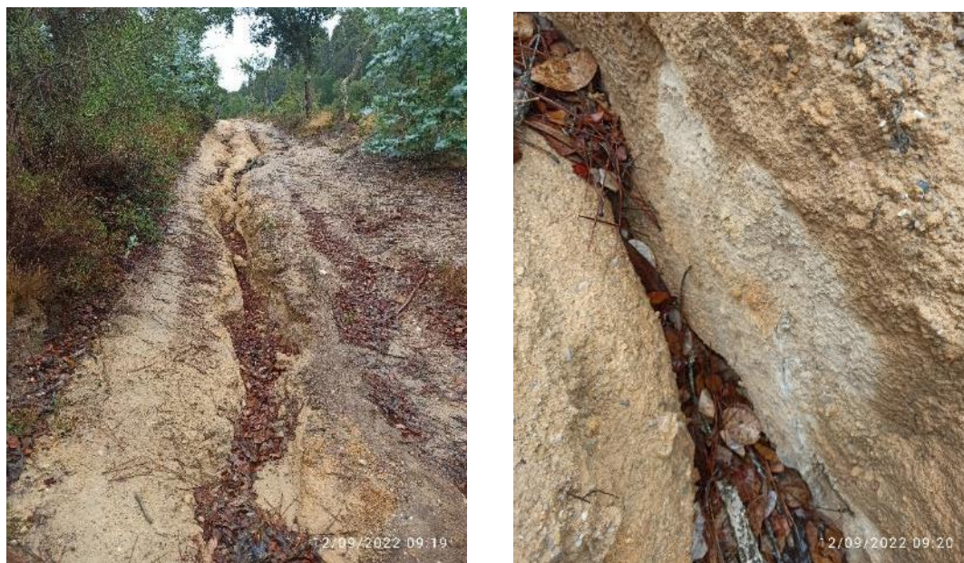
Figura 4 - Aspeto do acesso ao apoio 52
