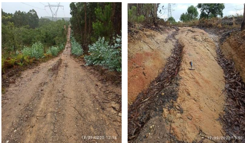
Figura 13 – Exemplos de acessos a melhorar, entre os apoios 45 e 44 (esq.) e próximo do apoio 42 (dir.)
