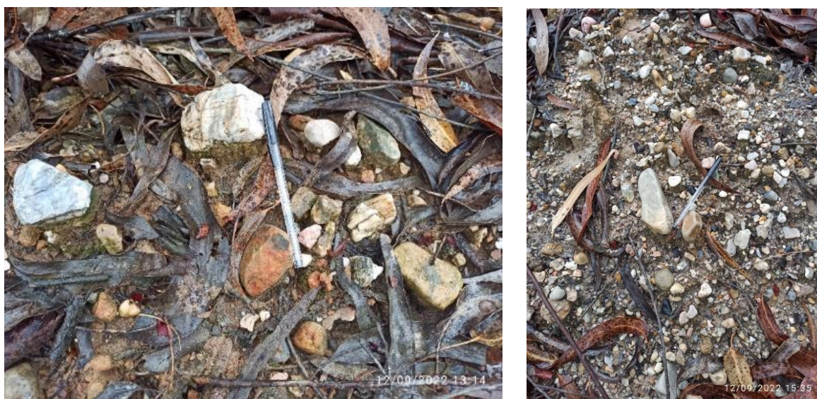
Figura 14 – Aspeto da camada superficial nos locais de implementação do apoio 48 (Esq.) e do apoio 41 (dir.)
